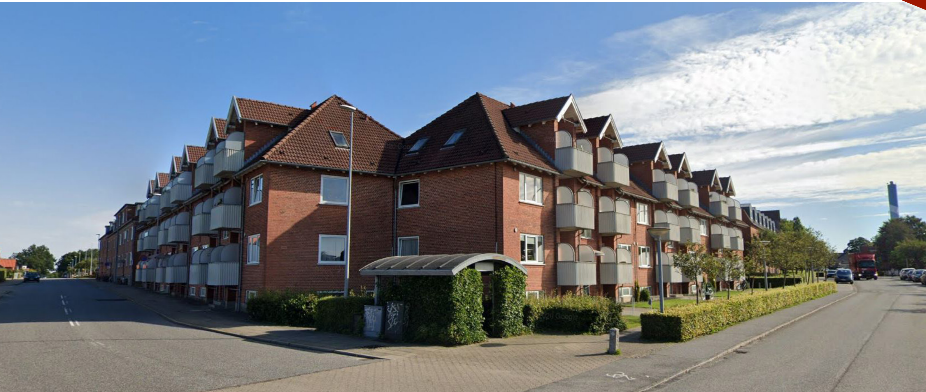
BLOK L&M - EKSISTERENDE UDTRYK ATYPISK FOR RESTERENDE BEBYGGELSE. STORE SADDELTAGSKVISTE OG UDHÆNG
