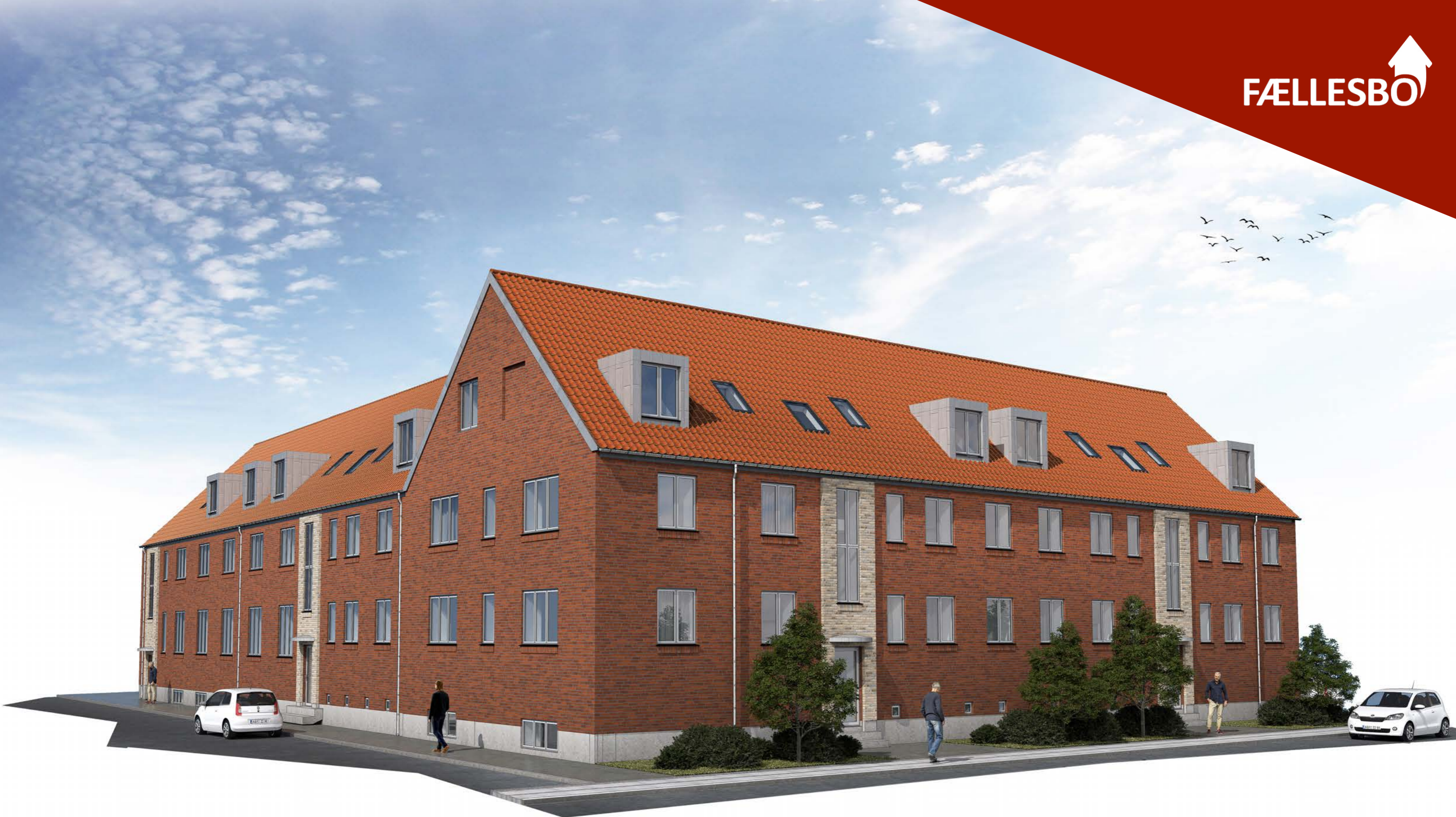
BLOK P - UDTRYK EFTER ENDT RENOVERING SAMME MUREDE DETALJER SOM RESTERENDE AFDELING
