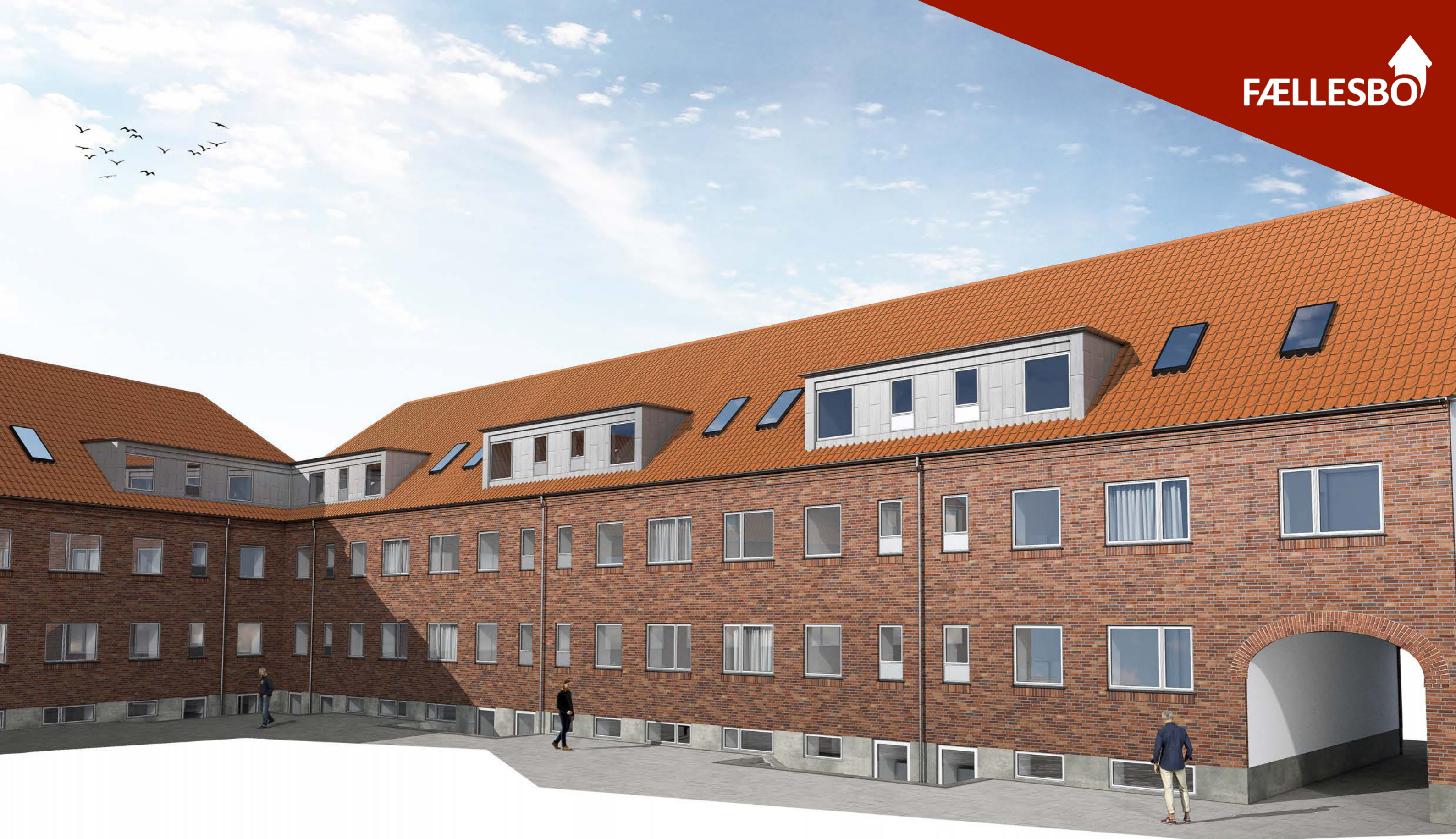
BLOK L&M - UDTRYK EFTER ENDT RENOVERING RENOVERING I SAMME STIL SOM RESTERENDE BEBYGGELSE
