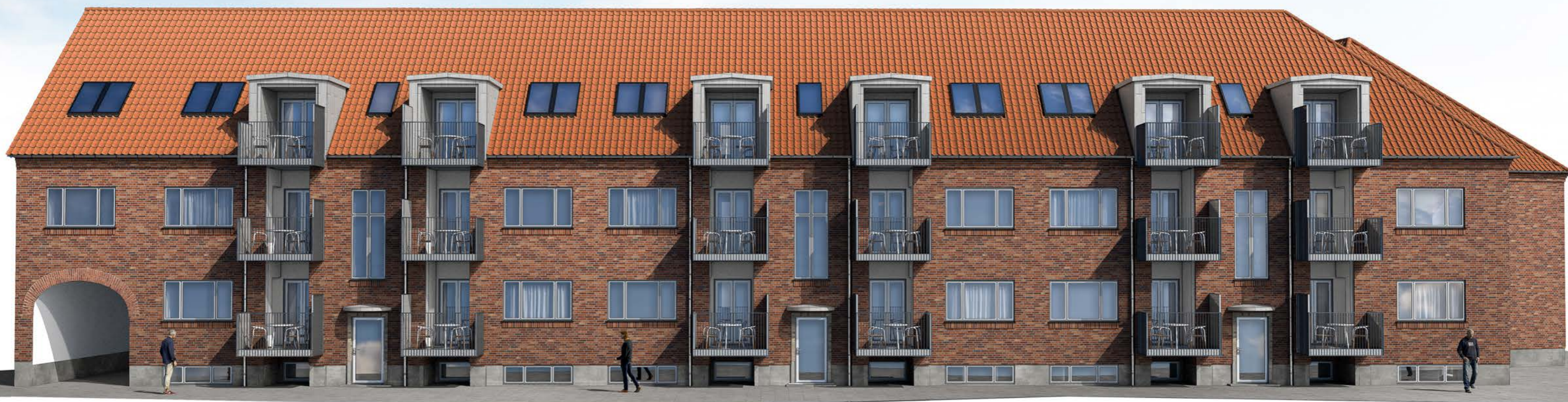
BLOK L&M - UDTRYK EFTER ENDT RENOVERING RENOVERING I SAMME STIL SOM RESTERENDE BEBYGGELSE
