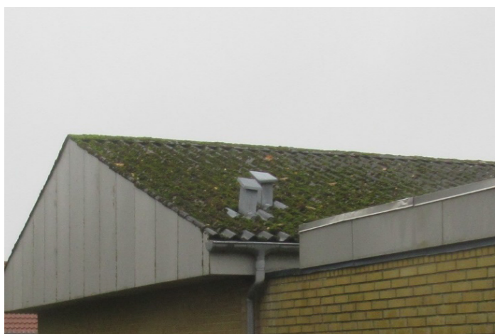
Eksempel på mosbegrøning på tagflade.
