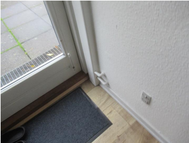
Eksempel på delvis synlig rørføring i nr. 13.
