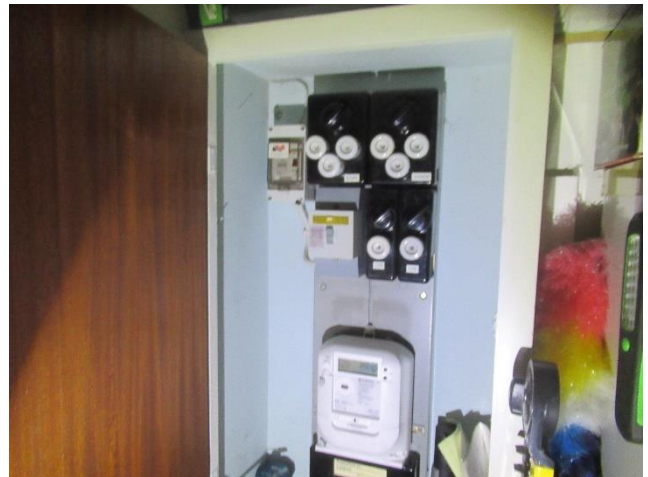
Eksempel på HFI-afbrydere og måler i nr. 18.
