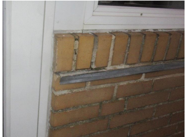
Eksempel på opbygning undervinduer i nr. 13.
