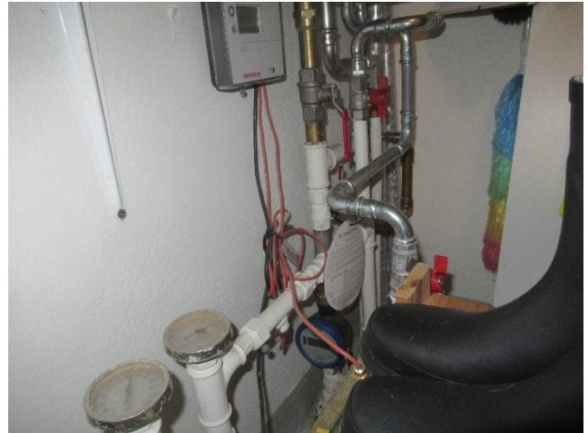
Eksempel på delvis udskiftning af installationer i nr. 20.
