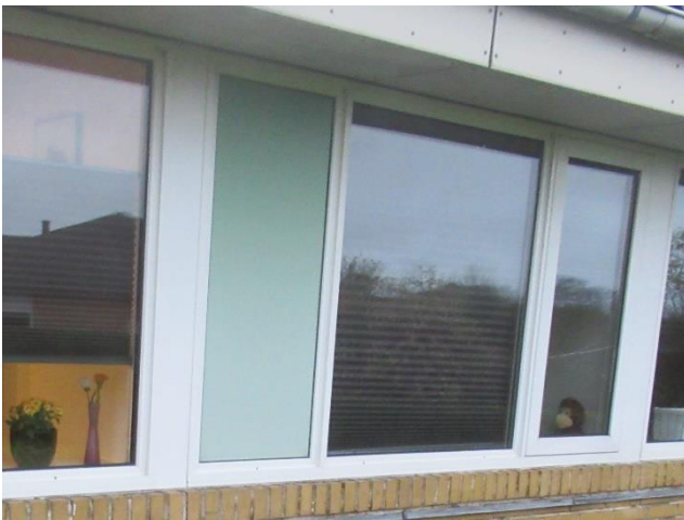
Eksempel på PVC – vinduer i facade i nr. 12.
