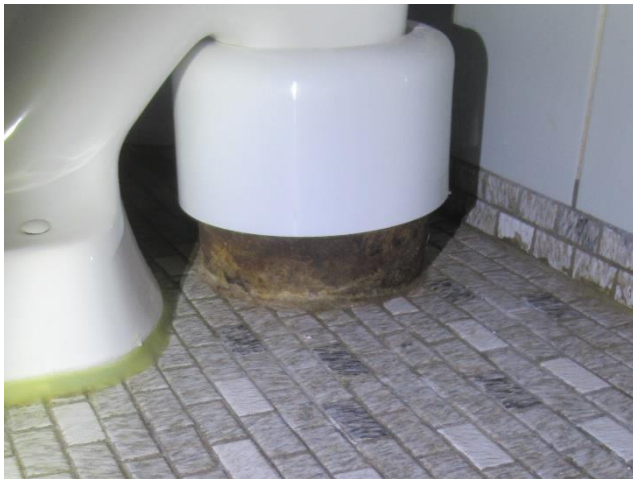
Eksempel på afløbsrør gennem terrændæk i støbejern. I nr. 13.
