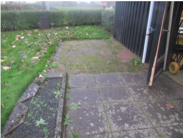
Eksempel på terrasse ved nr. 12.
