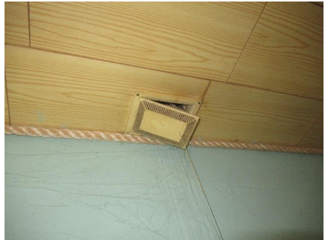
Eksempel på ventilering af toilet i nr. 18
