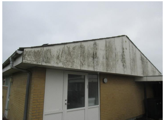
Eksempel på fibercement beklædning på gavltrekant i nr. 20.
