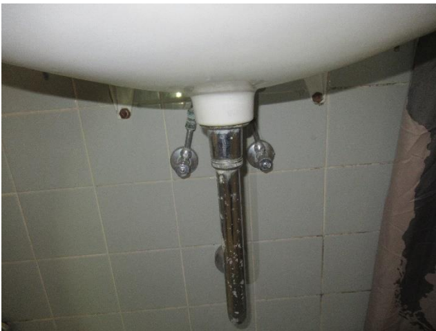
Eksempel på afløb fra håndvask i bad i nr. 13.
