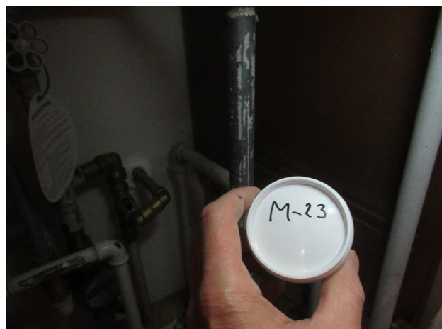
Prøve af maling på vandinstallationer (M-23).
